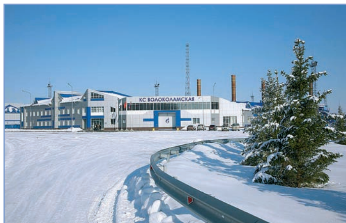
Рис. 1. Компрессорная станция "Волоколамская" ООО "Газпром трансгаз Москва"
