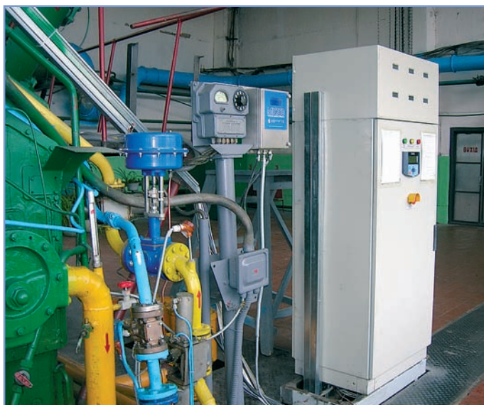
Рис. 4. Розташування ПТЗ САК ГМК "Пума 2.1" у залі ГМК на КС "Мрин" Мринського ПСГ УМГ "Київтрансгаз"
