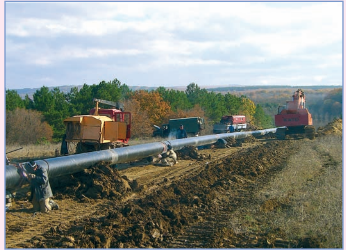
Будівництво газопроводу "Суворове-Залізничне" в АР Крим
